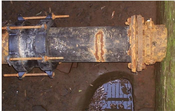
**Figura 03:** Adutora, ferro fundido 200mm
