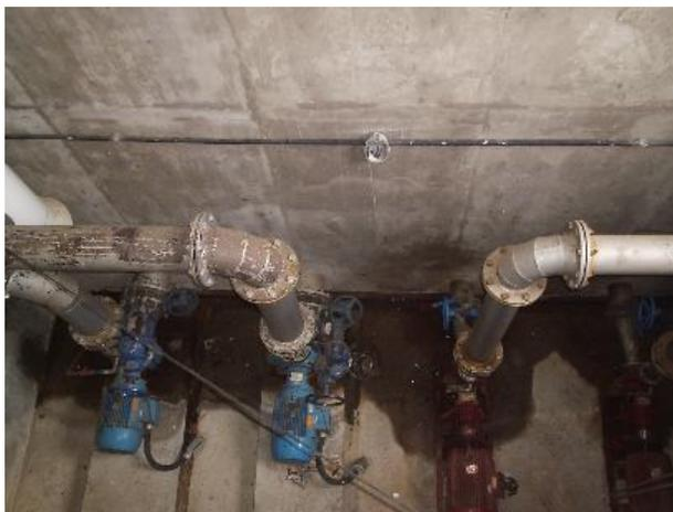
**Figura 06:** Bombeamento da água tratada para os reservatórios
